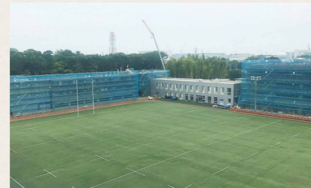
建設中の中学校校舎
