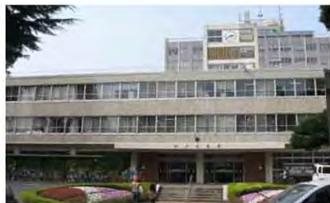
松戸市根本にある松戸市役所本庁舎
